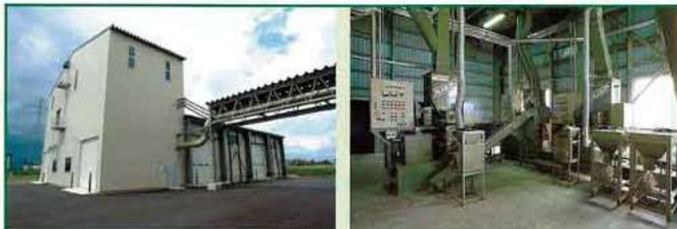
粃殻膨軟化処理施設 建築面積 600.00㎡ 機械能力 0.8t/h×プレスバンダー 3基
